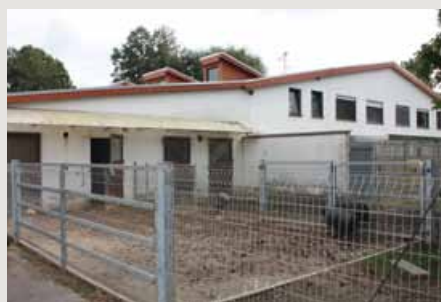
Der Stallbereich für die Schweine soll zur Hundunterkunft werden.
